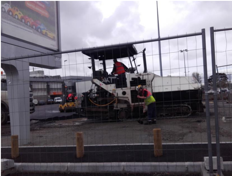
Site n° 16 : Travaux de voirie pour la modification de la circulation des véhicules aux abords de l'aérogare (présence importante d'engins de chantier)
