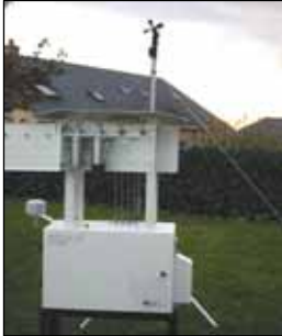
Nouveau système de collecte pour les prélèvements d'acide chlorhydrique et de métaux
