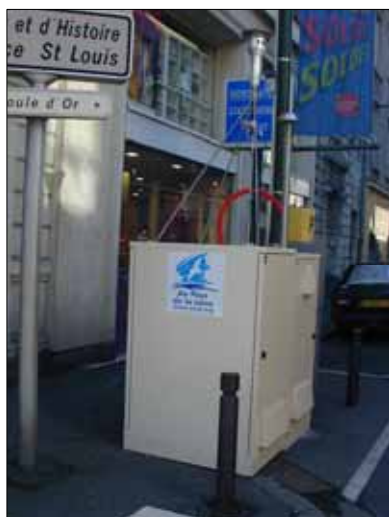
Photo 2 : armoires dans la rue Nationale
