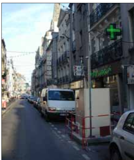
Photo 1 : armoires rue Maréchal Joffre
