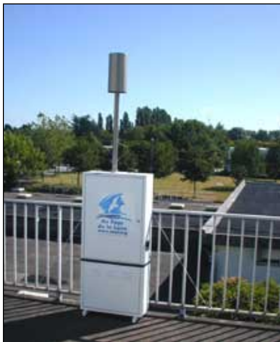
Collecteur haut débit (DA 80) à l'usine des Eaux
