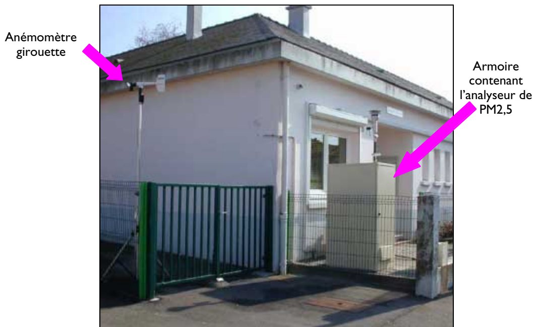
Photo 1 : station de mesure à l'école Pierre Marra
