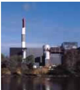
Usine d'incinération d'ordures ménagères Arc-en-ciel (Couëron)
