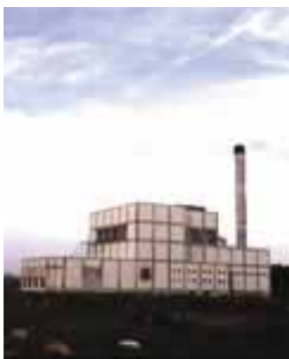
Usine d'incinération d'ordures ménagères Valorena (Nantes)
