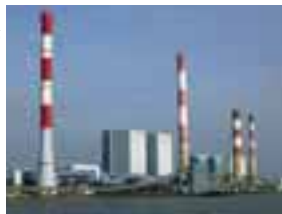
Centre de production thermique d'électricité de Cordemais
