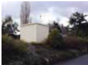
Station de mesure du groupe scolaire Saint-Exupéry
