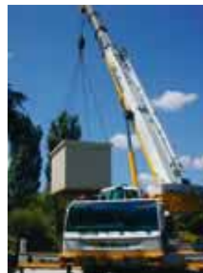
Pose de la cabine sur la station "Appentis" à Angers
