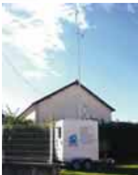
Laboratoire mobile au niveau du château d'eau du Friloux
