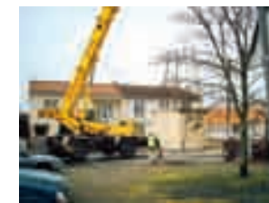
Installation de la cabine de la Roche-sur-Yon
