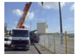
Installation de la cabine de Paimboeuf (Basse-Loire)
