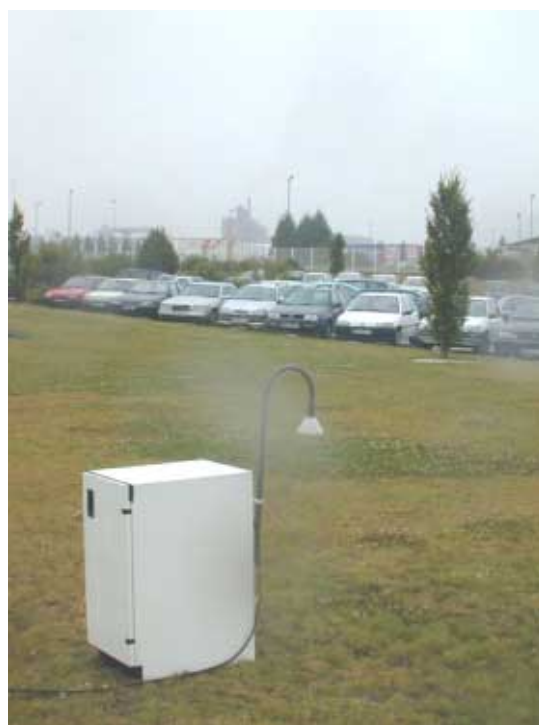
Système de collecte installé dans une armoire protectrice sur le site de Toyota
