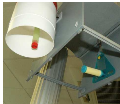
Figure 4 : tubes installés pour la collecte
