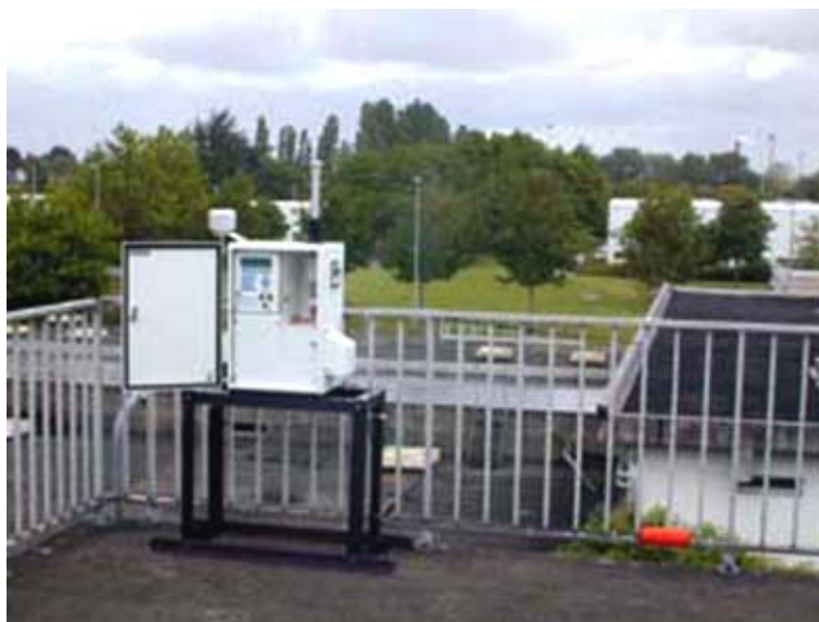
Collecteur moyen débit à l'usine des Eaux (Nantes)
