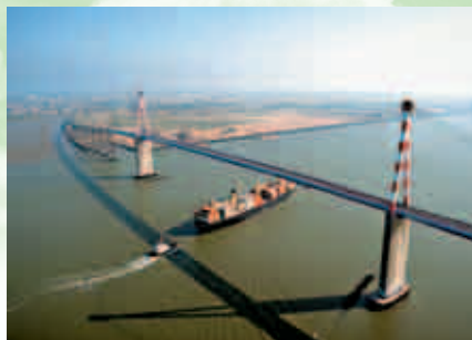
Le pont de Saint-Nazaire
