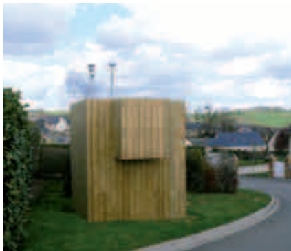
Station de surveillance de la qualité de l'air à Saint-Denis d'Anjou
