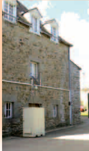
Station de mesure à Mayenne
