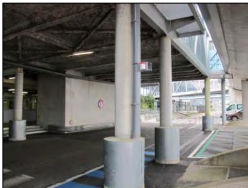
Photo 3: site n°13, zone stationnement avions face au Hall 3
