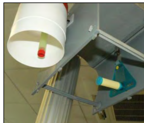
Photo 2 : tubes installés pour la collecte
