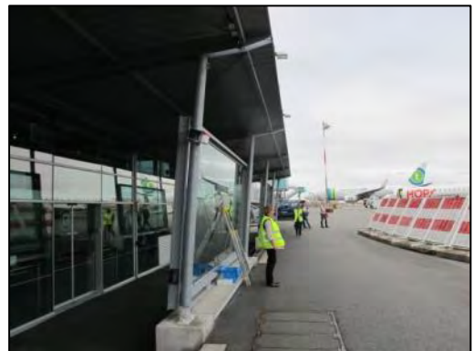
Photo 4: site n°14, zone stationnement avions face au Hall 4
