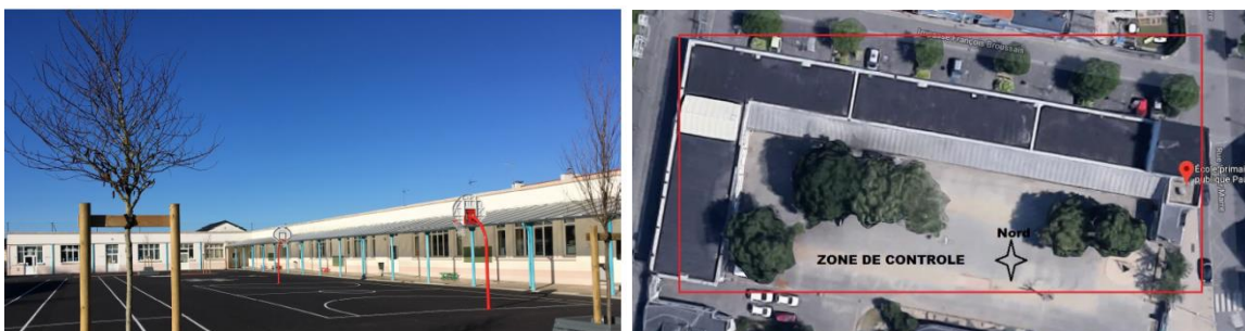
Figure 2: Photos des bâtiments de l'école Paul Bert
