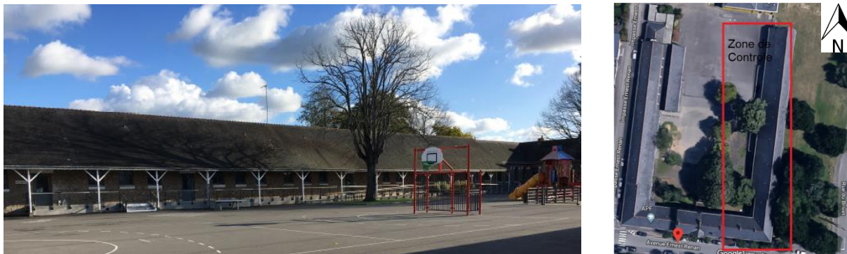
Figure 3: Photos des bâtiments de l'école Ernest Renan
