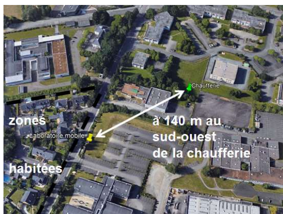
Emplacement du laboratoire mobile dans l'environnement de la chaufferie
