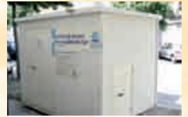
Cabine du boulevard Victor-Hugo à Nantes: grâce à ses panneaux d'information, les passants peuvent comprendre la fonction de cette station de mesure
