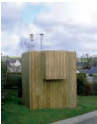
Station de surveillance de la qualité de l'air à Saint-Denis-d'Anjou
