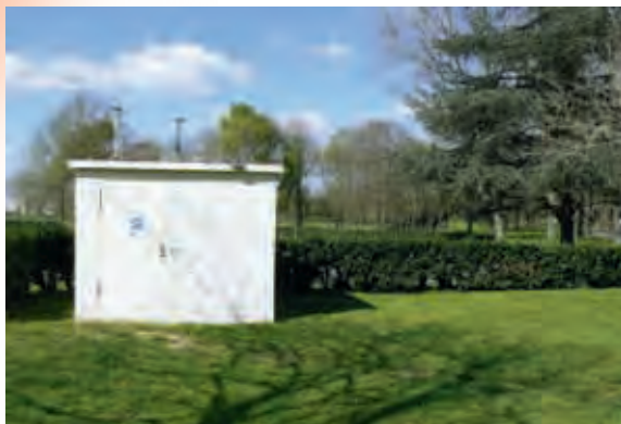
Station de mesure située au parc paysager
