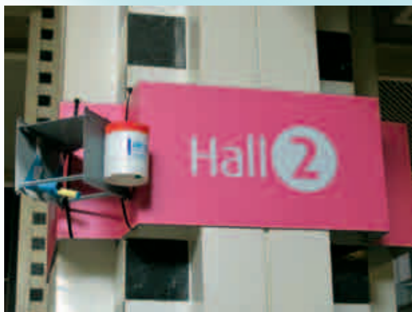
Dispositif de mesure dans le hall 2 de l'aéroport Nantes-Atlantique
