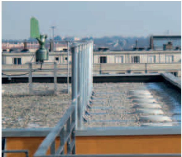
Le capteur de pollens d'Aéroc44 sur le toit de l'immeuble Champ-de-Mars à Nantes
