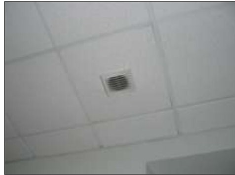
Photo 6 : présence de VMC simple flux au lycée David d'Angers
