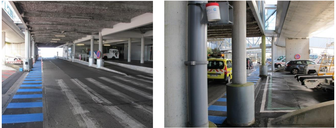
Typologie du site n°13 – confinement de la zone et circulations des véhicules des services de l'aéroport
