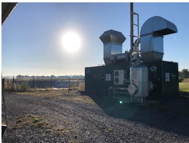
Figure 11 : cogénérateur de Derval Agri'méthane
