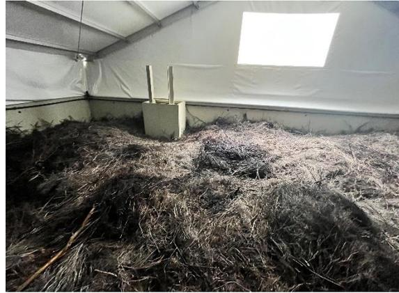
Figure 6 : vue intérieure du biofiltre
