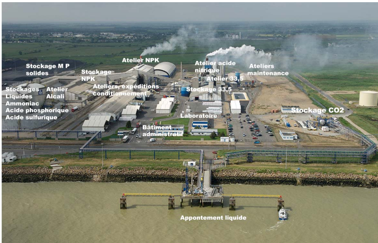
Photo 1 : vue aérienne de l'usine YARA de Montoir-de-Bretagne et localisation des installations.
