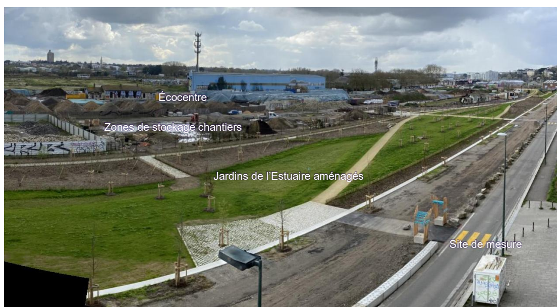
Photo 6 : vue sur le site de mesure, les aménagements et installations – mars 2026
