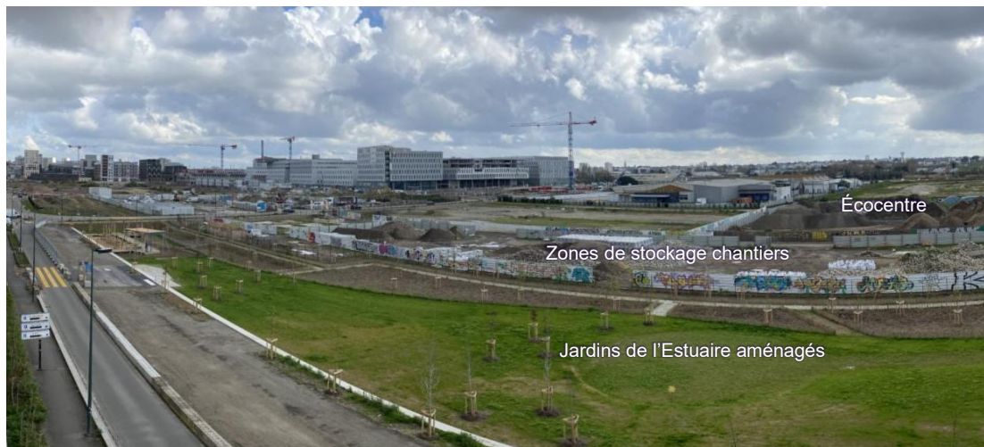
Photo 5 : vue sur les aménagements et installations – mars 2026
